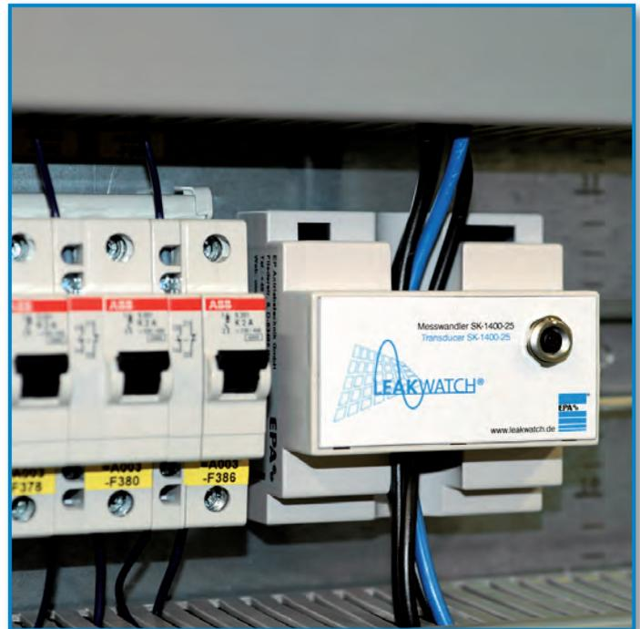
Wandler LW-SK1400-25 eingebaut im Schaltschrank zur permanenten Ableitstromüberwachung der Zuleitung.
